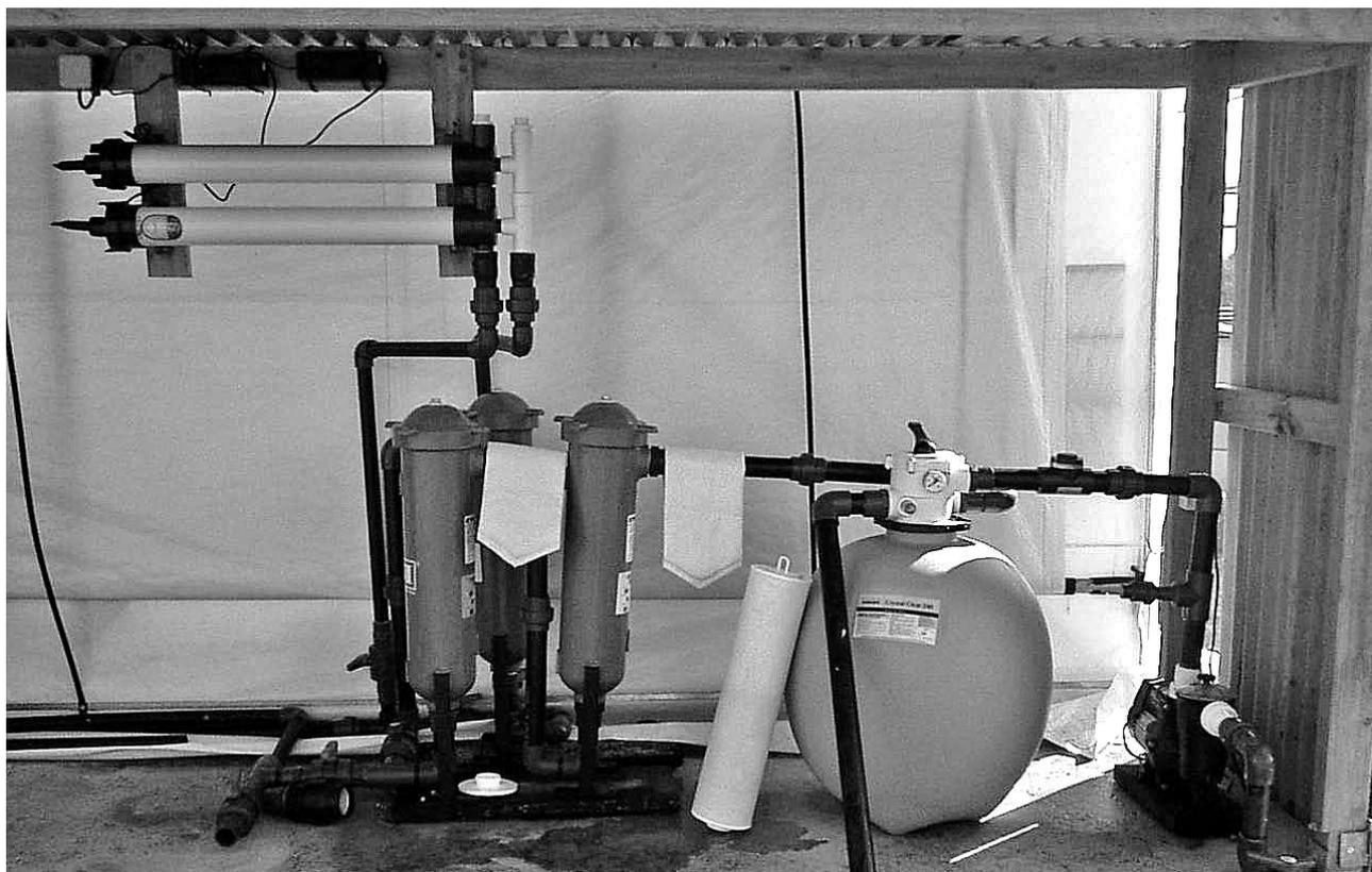
Figure 34. Système de filtration de l'eau de mer.
