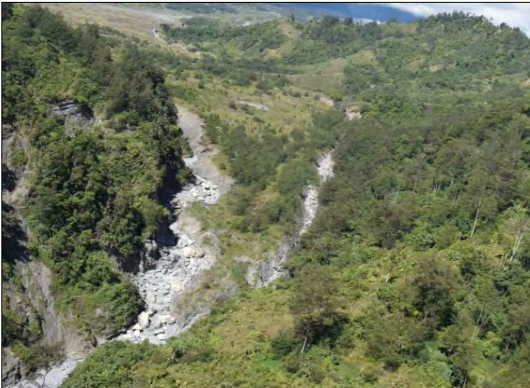
Figure 4-18 Anawe toe area
